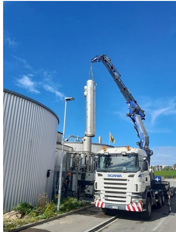
Bild 6: Demontage der Biogasanlage
