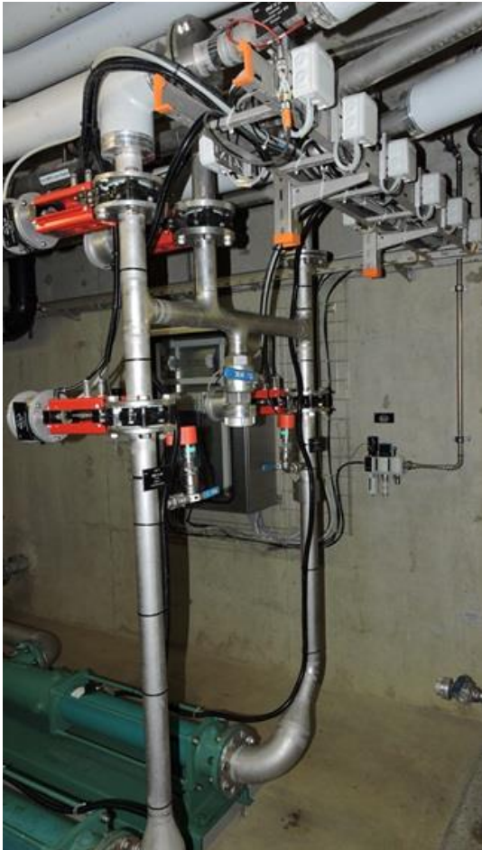
Bild 4: Nach dem Umbau
