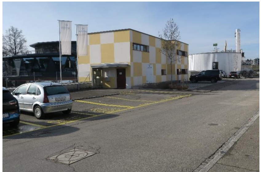
Abbildung 11: Der Eingangsbereich zum alten Betriebsgebäude wird durch die Sanierungsarbeiten wesentlich schöner und hochwertiger.
