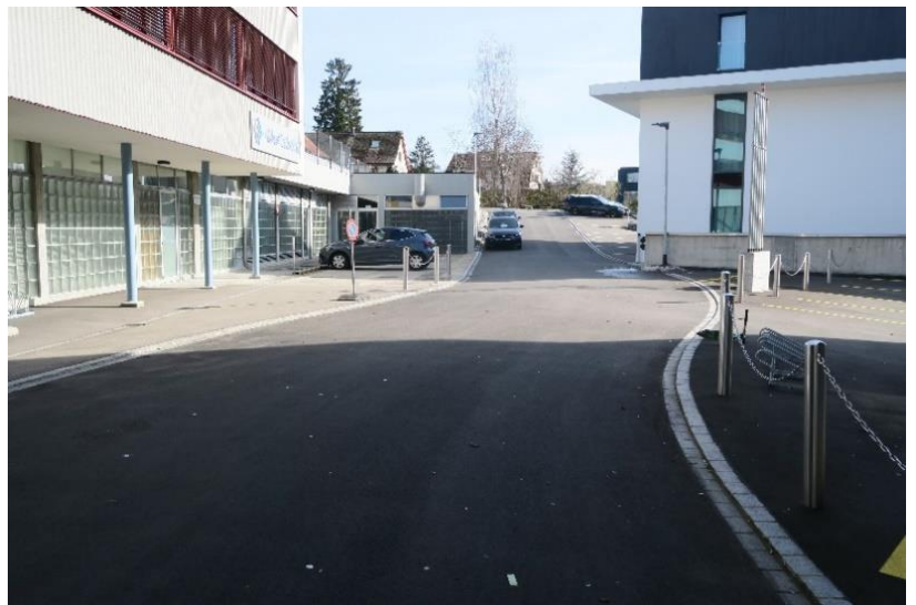
Abbildung 8: Im laufenden Jahr konnte der Deckbelag eingebaut werden. Der Ausbau des Gewerbegebiets Rorguet ist damit abgeschlossen.
