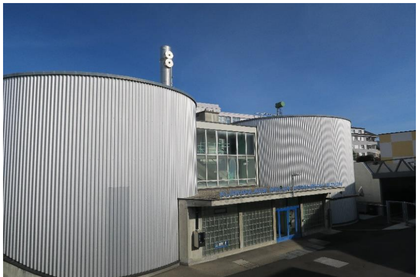
Abbildung 9: Der zusätzliche Schlamm der ARA Männedorf erfordert einen Umbau der Schlammfaulung.
