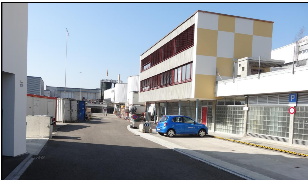
Zufahrtsstrasse ARA Ost / Neubau Arundo AG
