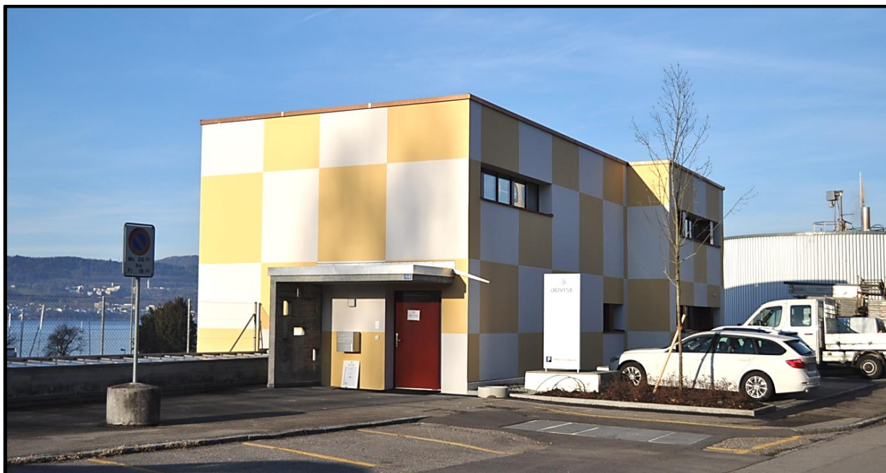
Das alte Betriebsgebäude wurde saniert und mit einem zusätzlichen Vollgeschoss versehen
