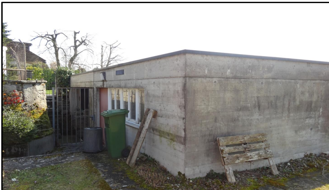
Das Pumpwerk Beugen soll in Zukunft intelligent und regelbasiert gesteuert werden
